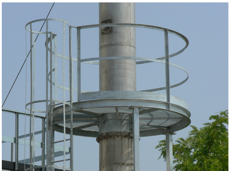
foto 3 Esempio di disposizione dei tronchetti di prelievo in camini con diametro > 50 cm foto 4 Esempio di piattaforma circolare con parapetto e scala di accesso
