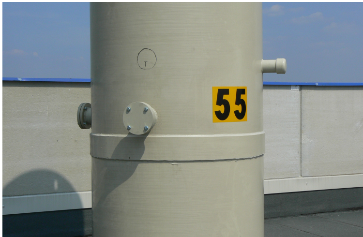
foto 1 e 2 Vista laterale e frontale del tronchetto di prelievo da 4" flangiato. Si noti la presenza anche del foro da 2"½.
