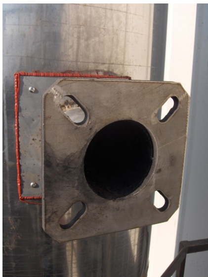
Esempio di tronchetti di prelievo da 4" flangiati
