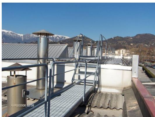
Collegamento che consente l'ispezione di tutti i camini
